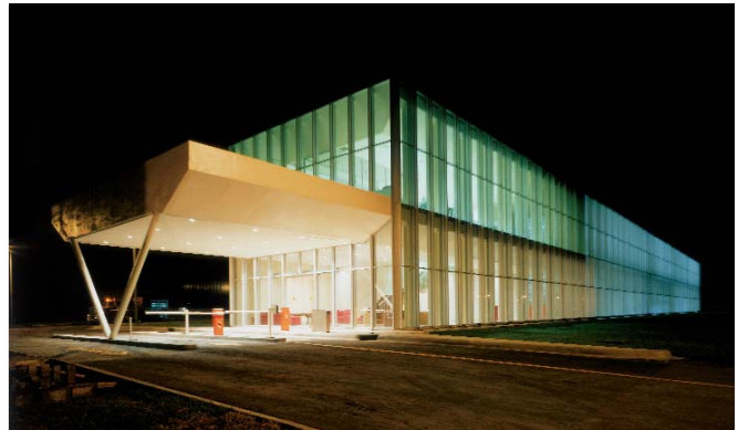
▲ Vista exterior del Centro de Componentes Automotrices de Tenaris.
