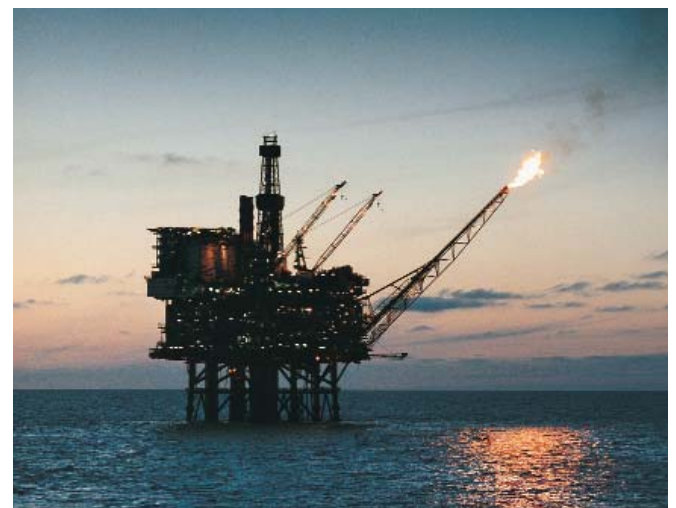
▲ Los tubos de línea tienen una nueva aplicación: construcción de plataformas.
