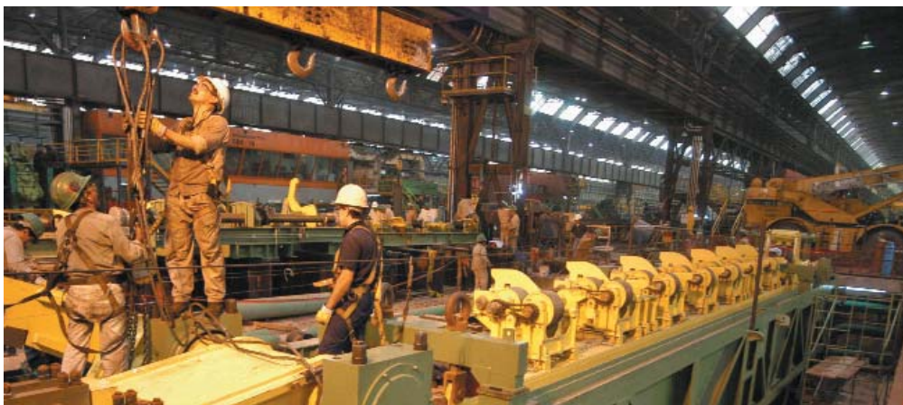
▲ La instalación de la nueva tina de temple permitirá mayor control sobre el producto final.
